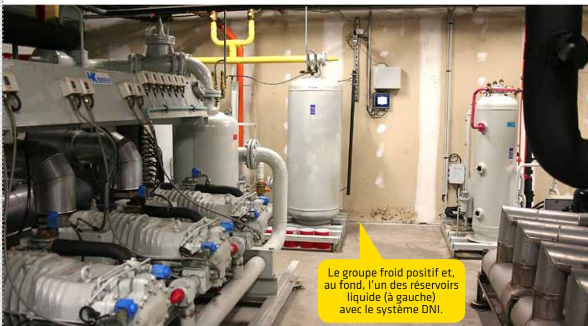
Le groupe froid positif et, au fond, l'un des réservoirs liquide (à gauche) avec le système DNI.
